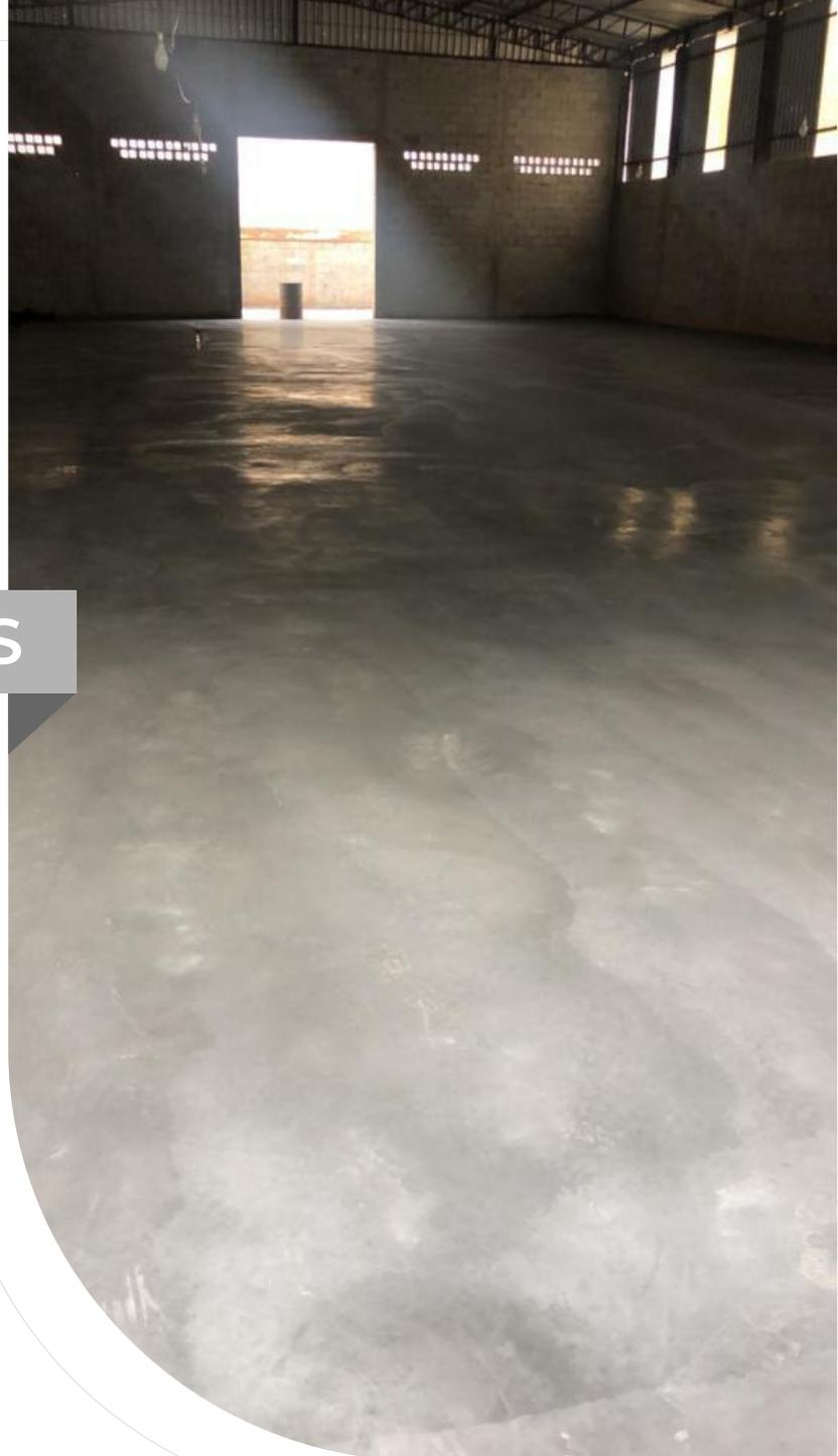
CONSISTE EM CONCRETO ARMADO, POLIMENTO MECÂNICO, E NIVELAMENTO A LASER, COM CÁLCULOS ESPECÍFICOS DE TRAÇOS DE CONCRETO ARMADOS E FIBRADOS, PARA ATENDER O ALTO TRÁFEGO.
